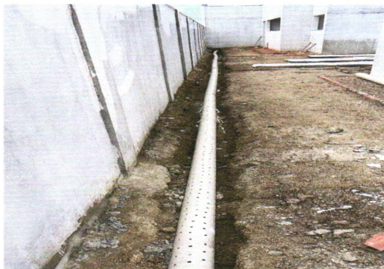
FOTO 191: CONFEÇÃO DE DRENAGEM (LATERAL ESQUERDA)
